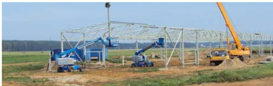
Строительство самолетного ангара «Лавери» (Латвия)
