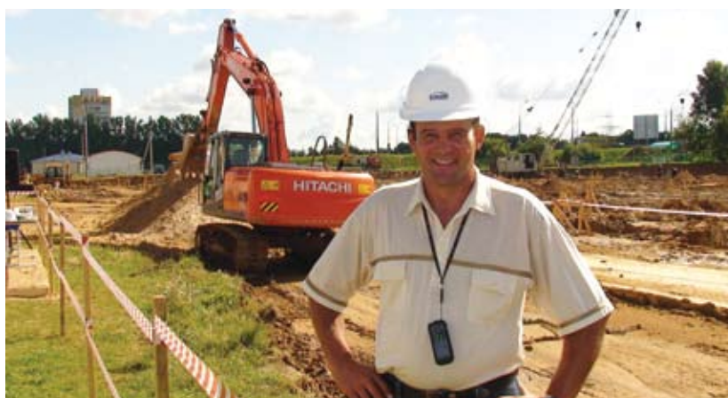
Прораб В. Кузь на строительстве супермаркета «Ома» в Минске (Беларусь)
