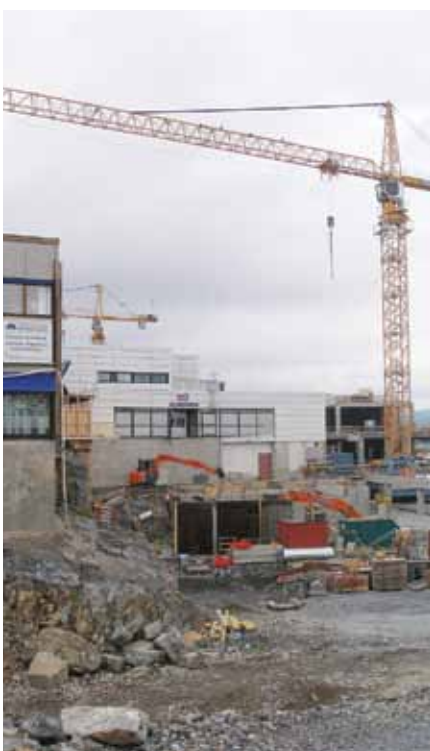
Строительство торгового центра в Норвегии.
