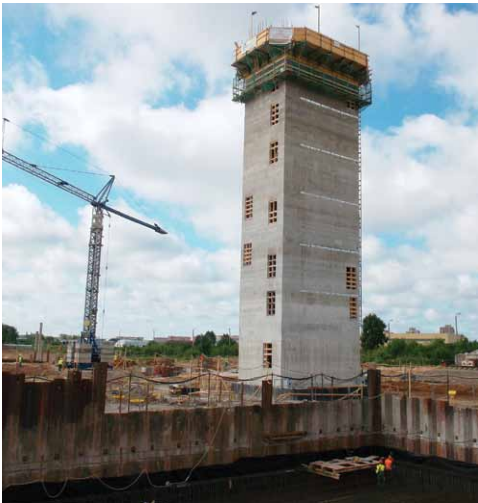
Строительство термофикационной электростанции в г. Клайпеда (Литва).
