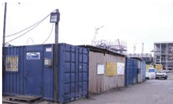
1 место – строительный городок объекта «Комплекс по глубокой переработке маслосодержащих культур»
