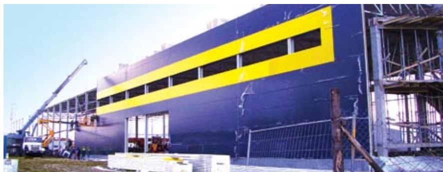
Строительство складских помещений ЗАО «Vitranasa» (Литва)
