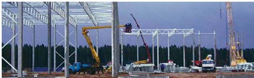
Монтаж металлоконструкций терминала логистики UAB «Bildunga» (Литва)
