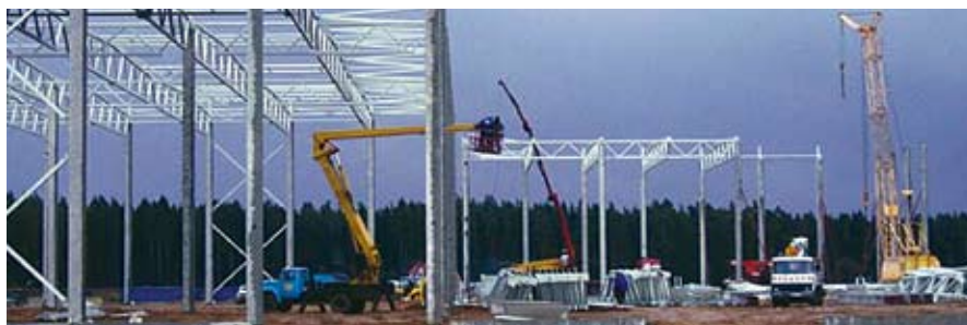
UAB „Bildunga“ (Vilniuje) logistikos terminalo metalinių konstrukcijų montavimo darbai
