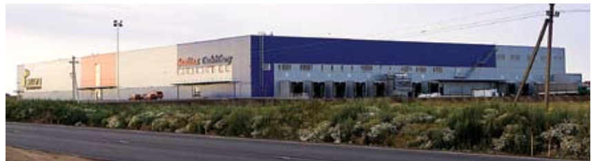
Складской и торговый центр «Sanitex» (Литва)
