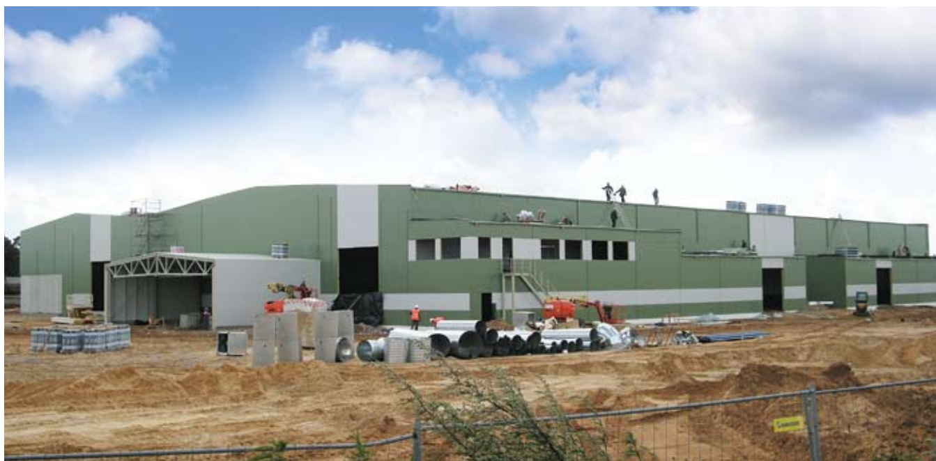
Строительство производственного цеха «Šilutės durpės», площадью 9056 м 2 (Литва)
