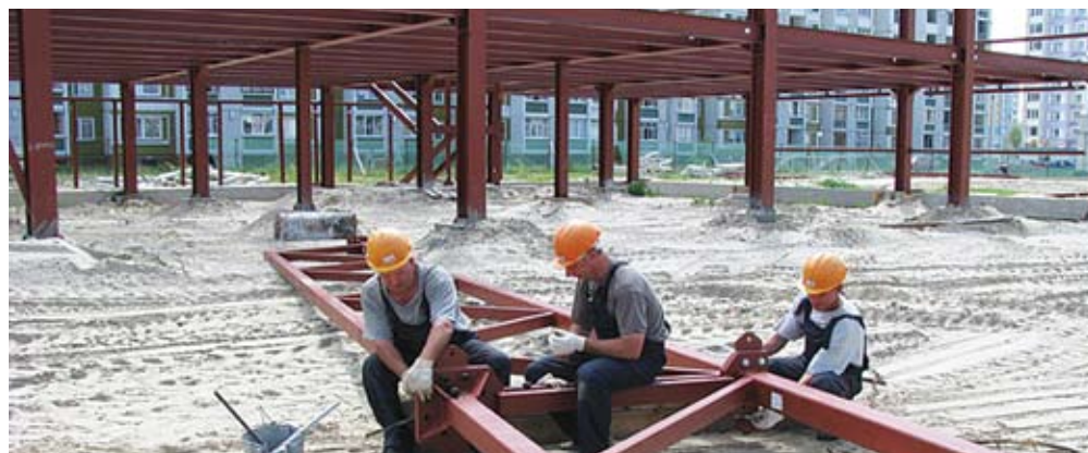
Строительство супермаркета «Алми» в городе Гомель (Республика Беларусь).
