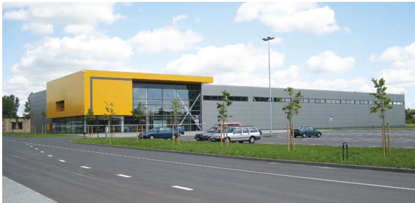
Торговый центр строительных материалов «Mokė vežis» общей площадью в 7400 м 2 , в городе Шяуляй (Литва)
