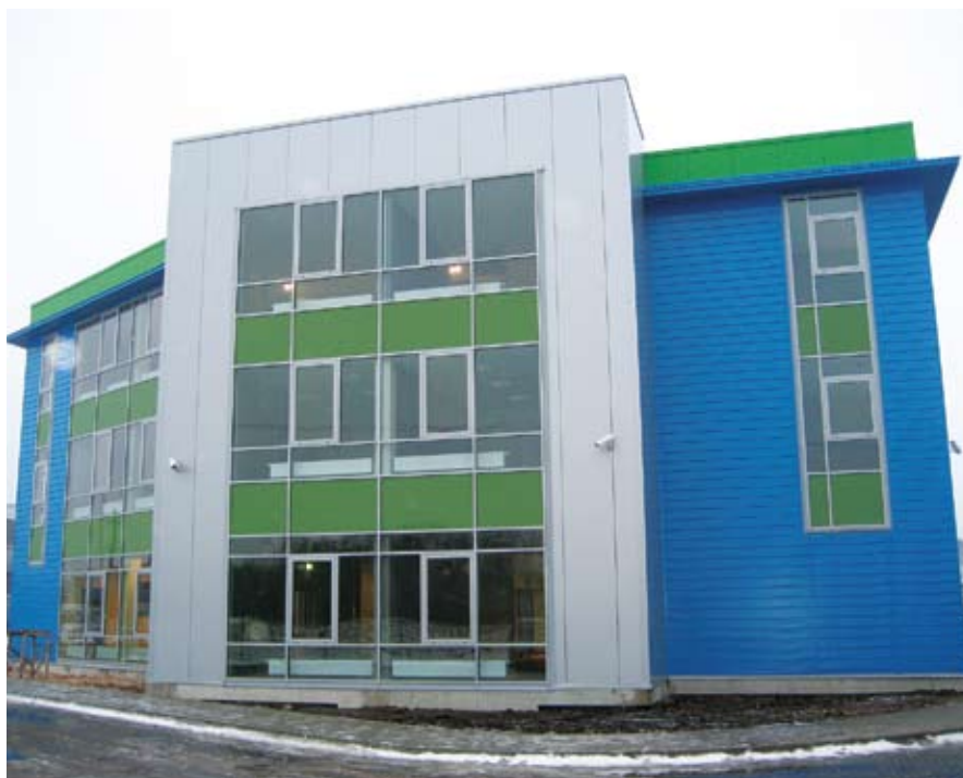
Строительство склада с офисными помещениями «Basko» (Латвия)
