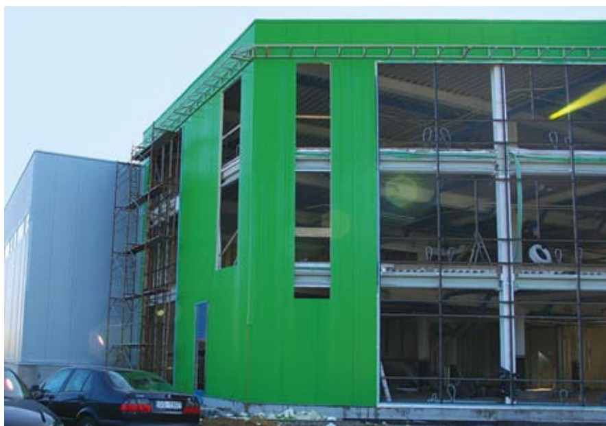
Строительство склада с офисными помещениями «Basko» (Латвия)
