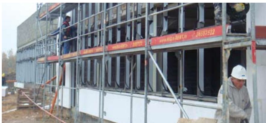
Строительство складского комплекса по заказу ЗАО «Konstanta tvis» (Латвия)
