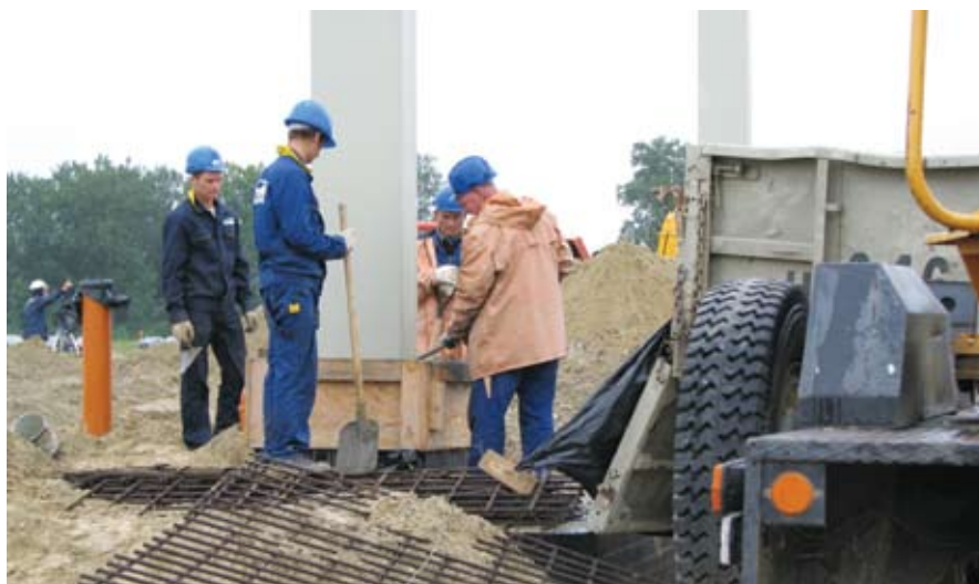
Строительство терминала логистики «ДСВ» (Калининград)
