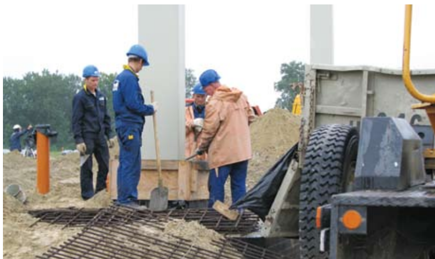
Logistikos terminalo „DSV“ (Kaliningrade) statyba
