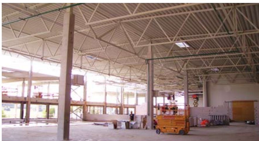
Строительство типографии с административным зданием ЗАО «PakMarkas» в вильнюсском районе (Литва)
