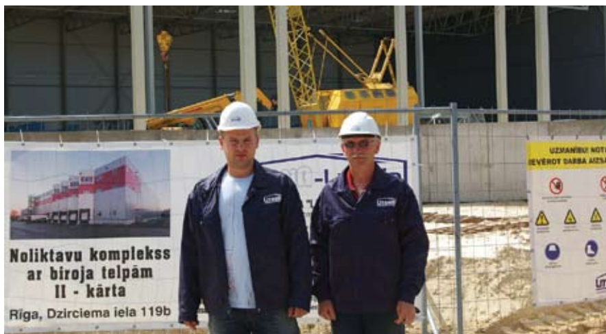
Руководитель проекта Олег Пиненков и начальник участка Виктор Жукков на строительстве склада компании «Eugesta» (Латвия)
