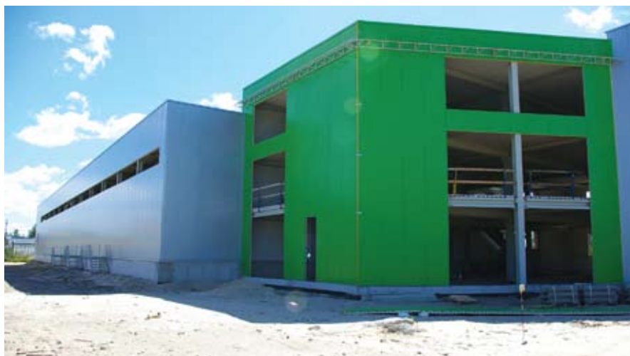
Строительство склада приправ с офисными помещениями «Basko» (Латвия)
