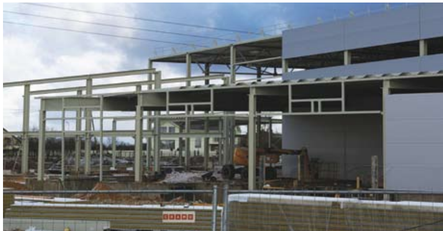
Строительство складского комплекса с административным зданием и выставочным залом по заказу SIA «Konstanta tvis» (Латвия)
