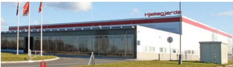
Завод ЗАО «Hjellegjerde Baltija», 5900 м 2 , г. Паневежис Литва
