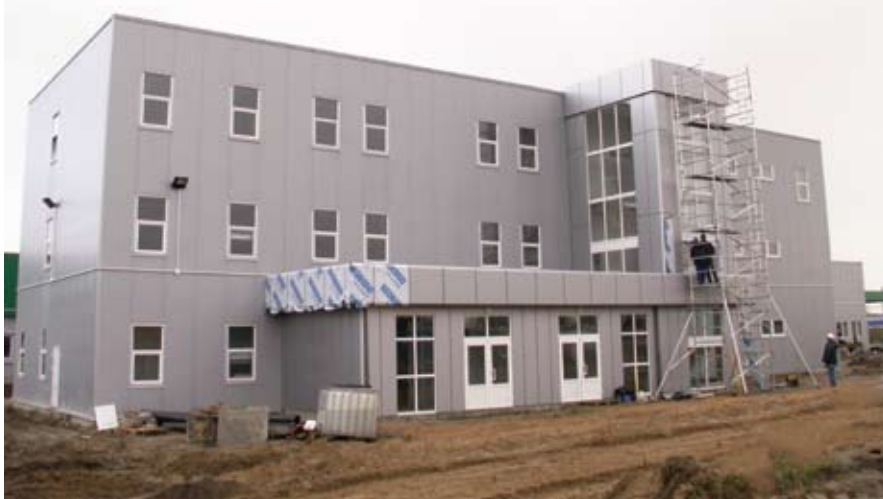
Строительство рыбоконсервного комплекса фирмы «Роскон» (Калининград)
