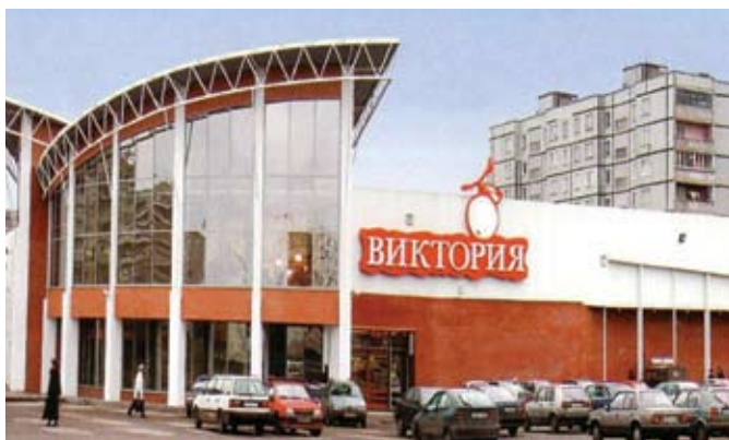
Торговый центр «ВИКТОРИЯ», 8500 м 2 , Калининград. Во время проектирования здания приняты оригинальные архитектурные решения
