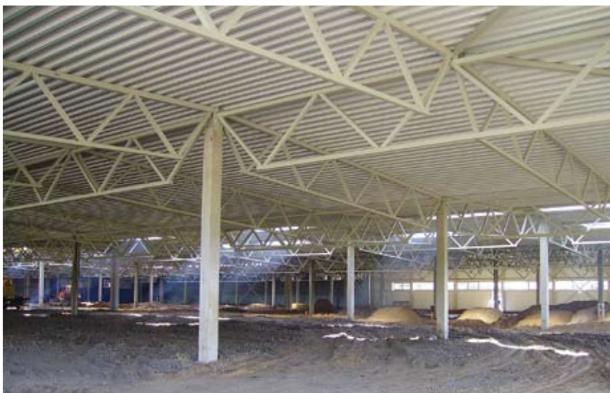
Строительство цеха по сборке мебели ЗАО «Mažeikių lyga» (Литва)
