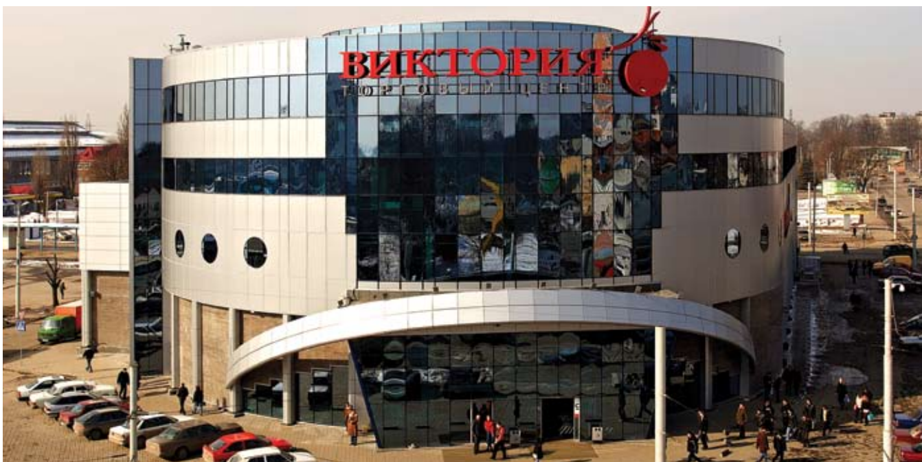
Торговый центр «ВИКТОРИЯ», 11500 м 2 , Калининград. Выполнены работы генпродрайчика. Спроектирован и построен за 6 месяцев
