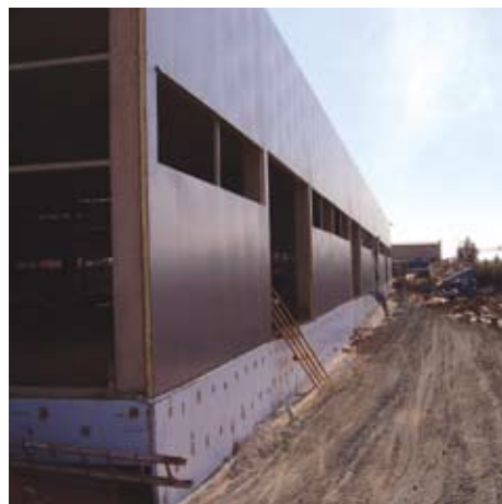
Строительство цеха по сборке мебели ЗАО «Mažeikių lyga» (Литва)
