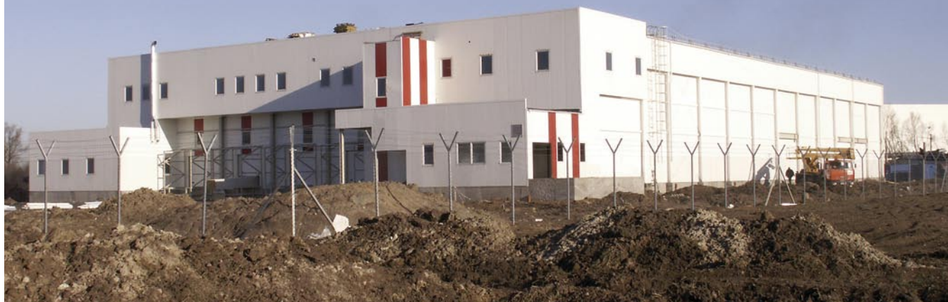
Строительство холодильника-распределителя (Калининград)
