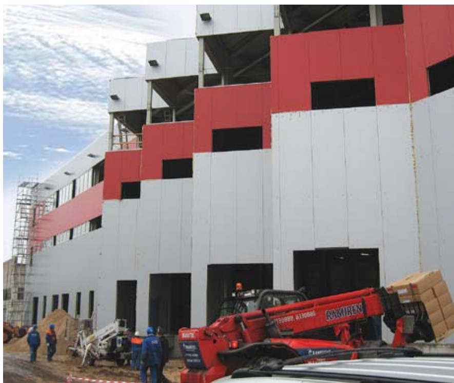
Строительство складских помещений центра логистики «Eugesta» (Латвия)
