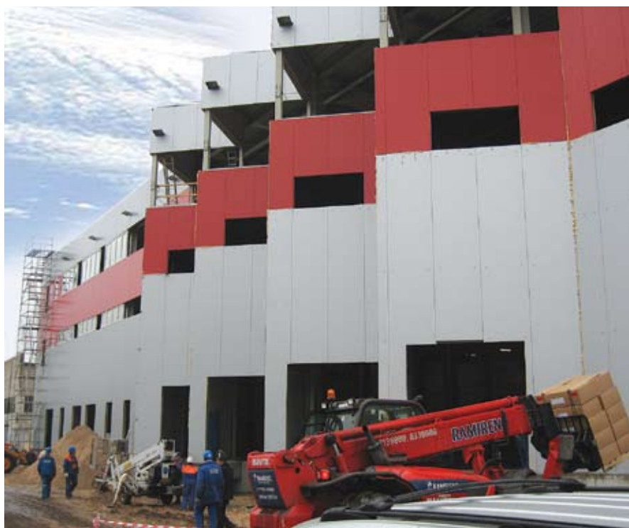
Logistikos centro «Eugesta» sandėliavimo patalpų statyba (Latvija)
